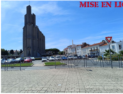
5. Vue façade Est depuis la place Notre-Dame
