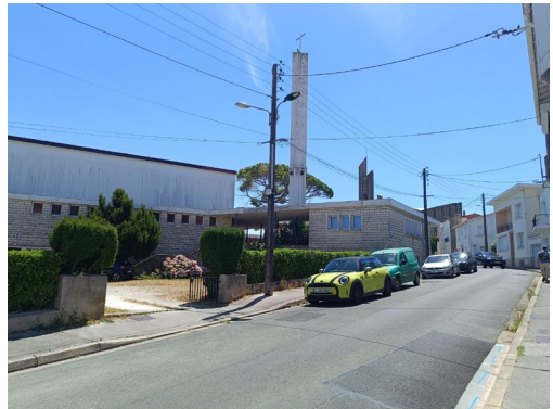
10. Vue de l'angle Nord depuis la rue Alsace-Lorraine
