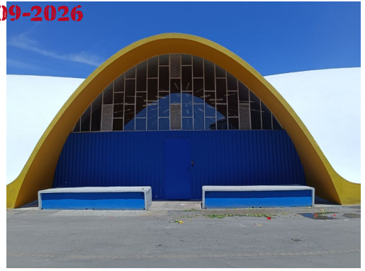
6. Vue de la façade Sud depuis la rue Henri Mériot
