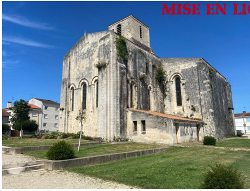
5. Vue de l'angle Sud-Est
