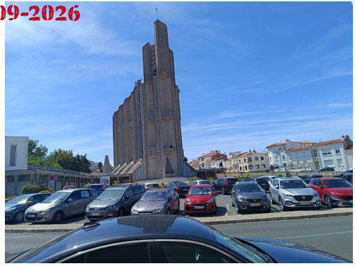
6. Vue angle Sud-Est
