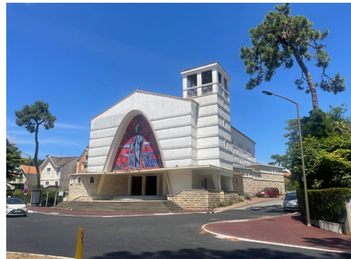
2. Vue de l'angle Sud-Est de l'Eglise depuis l'avenue Emile Zola
