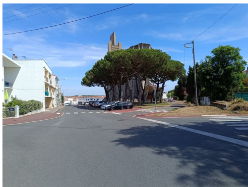
3. Vue Nord-Ouest depuis la rue du Champ des Oiseaux
