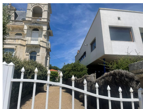
4. Façade latérale Nord-Ouest
