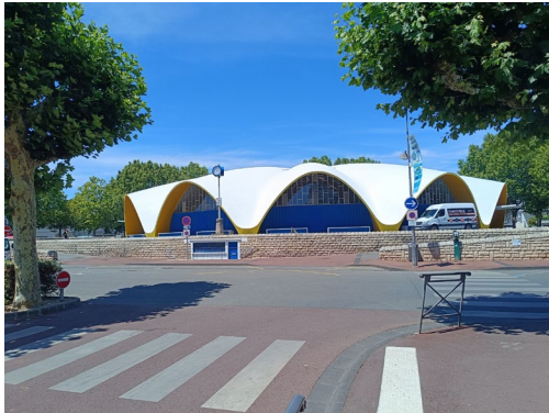
7. Vue façade Sud depuis le boulevard Aristide Briand
