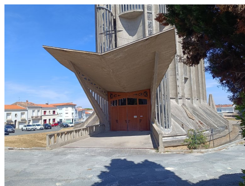
2. Vue de l'entrée sur la façade Ouest
