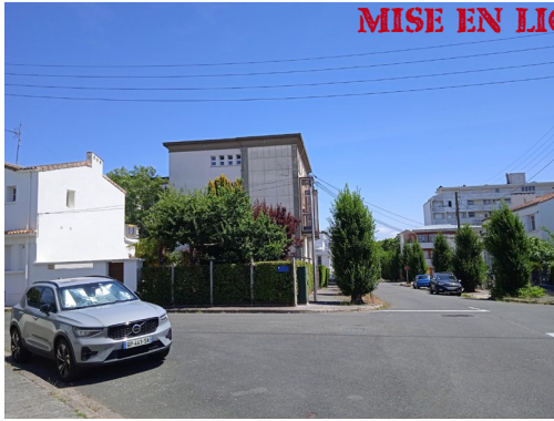
5. Façade Nord-Ouest depuis la rue Jean Gouly
