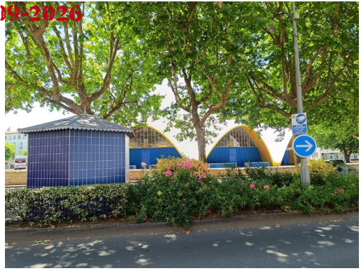
12. Vue façade Est depuis la rue Font de Cherves
