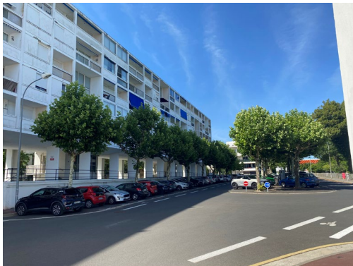
15. Vue Nord-Est depuis l'angle Nord sur l'avenue des Congrès
