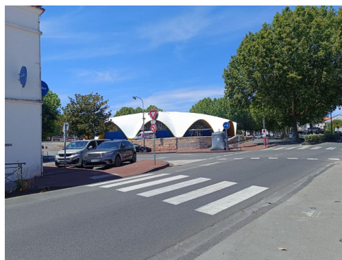
8. Vue Sud-Est depuis la rue Font de Cherves
