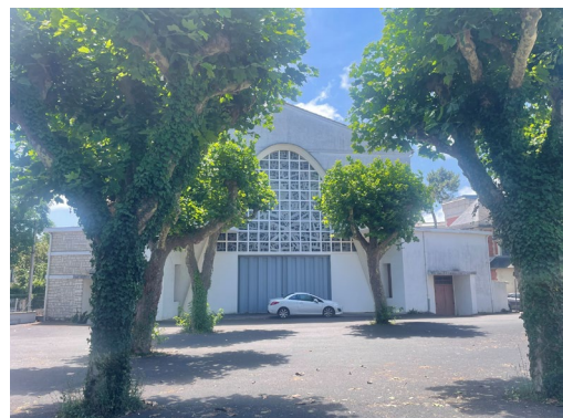
4. Vue de la façade Nord depuis l'allée des Marronniers
