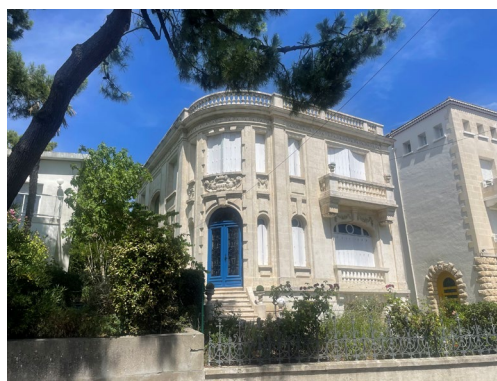
2. Vue sur l'entrée de la maison
