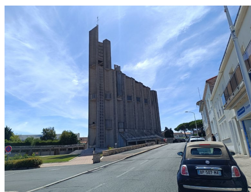
4. Vue angle Nord-Est depuis la rue du Château d'eau
