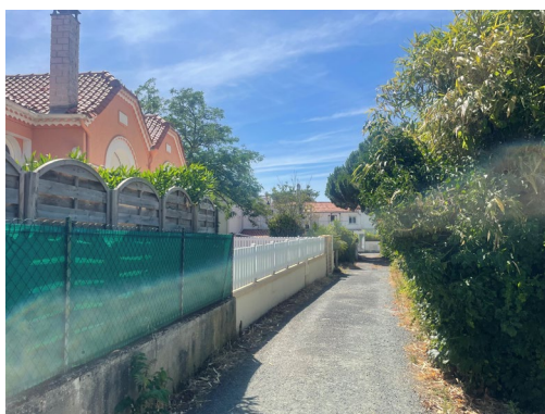
1. Vue Ouest sur la maison depuis l'allée des Marronniers
