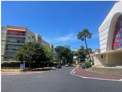
9. Vue Nord-Ouest vers l'avenue Emile Zola depuis la façade Sud de l'Eglise (av. E.Zola)
