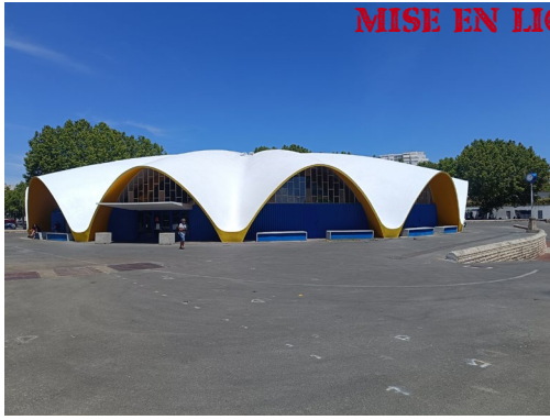
5. Vue de la façade Sud
