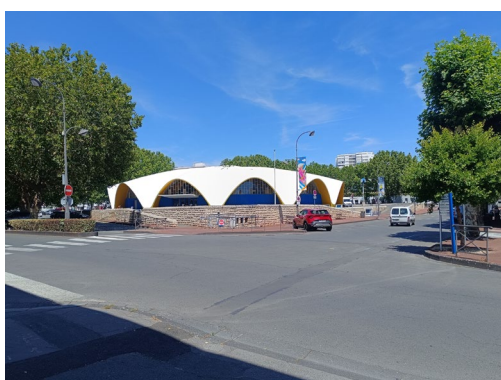
3. Vue Sud-Ouest depuis la rue Pierre Loti
