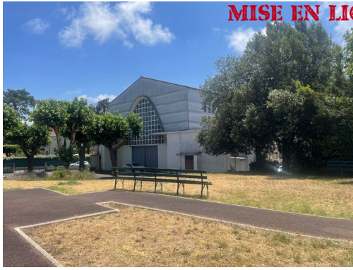
5. Vue de l'angle Nord-Ouest depuis l'intérieur de la parcelle
