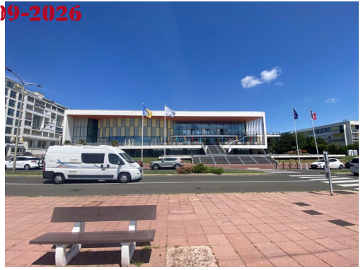
6. Vue façade Sud-Ouest depuis la façade de Foncillon
