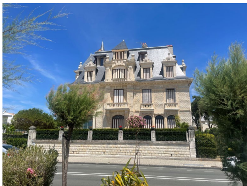
1. Façade Sud-Ouest côté mer
