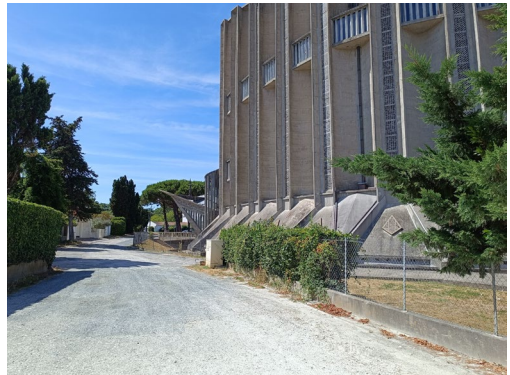
10. Vue de la façade Sud
