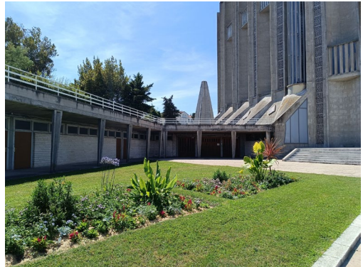
8. Vue des abords au niveau de l'angle Sud-Ouest
