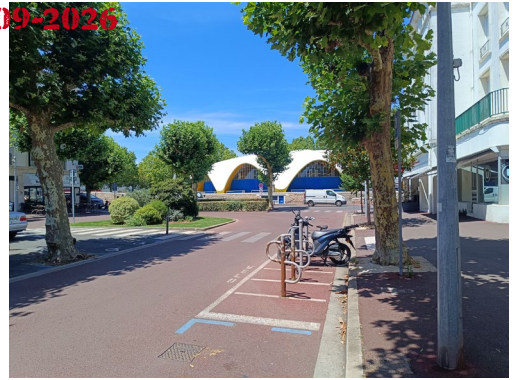
12. Vue façade Sud depuis le boulevard Aristide Briand
