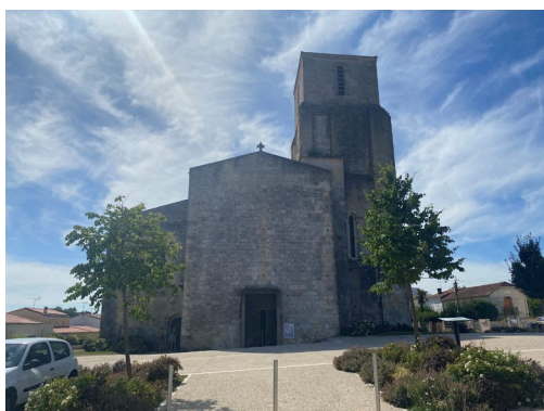
1. Vue façade nord depuis la rue du Clouzit
