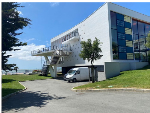
7. Vue Sud-Ouest depuis l'angle Est
