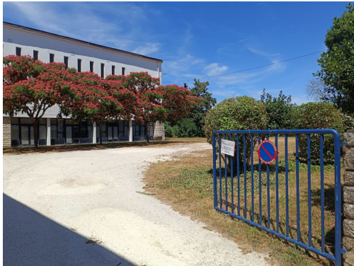
7. Vue de la façade Sud depuis la rue Eugène Pelletan
