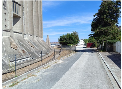
2. Vue angle Sud-Est
