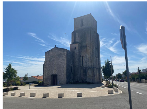
12. Vue façade Nord depuis le Boulevard Georges Clemenceau
