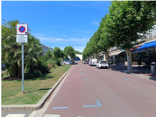
13. Vue façade Sud depuis le boulevard Aristide Briand
