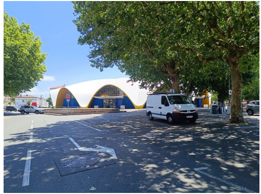
14. Vue façade Nord
