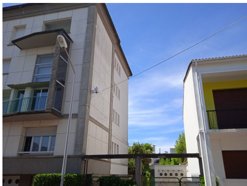
1. Vue vers le Nord-Ouest depuis la rue Foncillon
