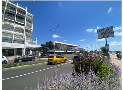
8. Vue Sud-Est depuis la façade Foncillon
