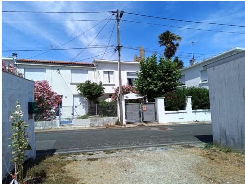
13. Vue Sud-Ouest depuis la rue des Moulins
