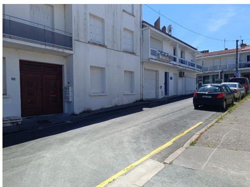
5. Vue Sud-Ouest vers la rue Eugène Pelletan
