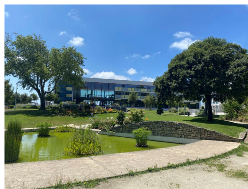
2. Façade Nord-Est dans son contexte
