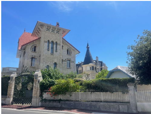
9. Vue Sud depuis l'avenue Emile Zola
