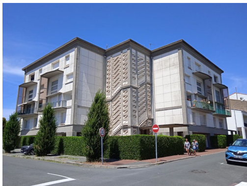
1. Angle Sud du bâtiment
