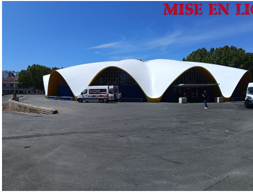
11. Vue de la façade Est
