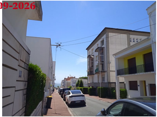
6. Façade Sud-Est rue de Foncillon
