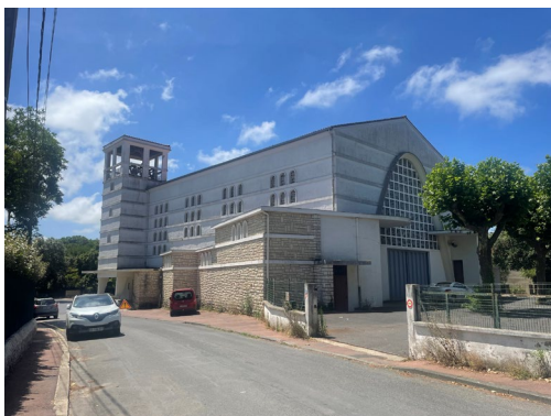
3. Vue de l'angle Nord-Est depuis l'avenue Saint-François
