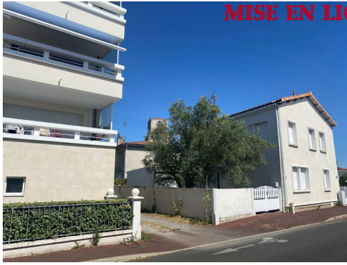
5. Vue depuis la rue de la Providence
