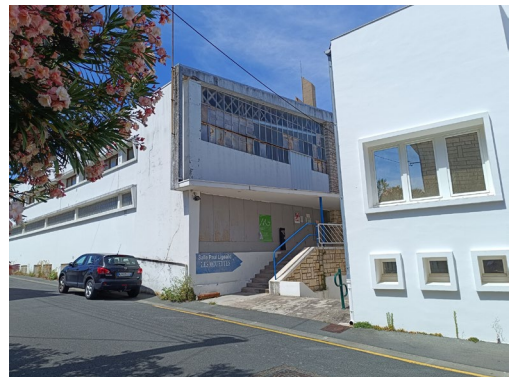
22. Vue du clocher depuis la rue du Printemps
