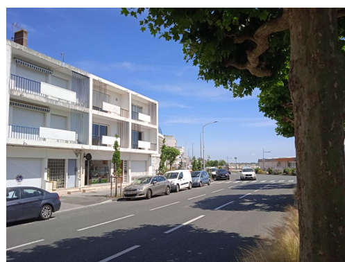
4. Façade depuis le parking du Boulevard de la Grandière
