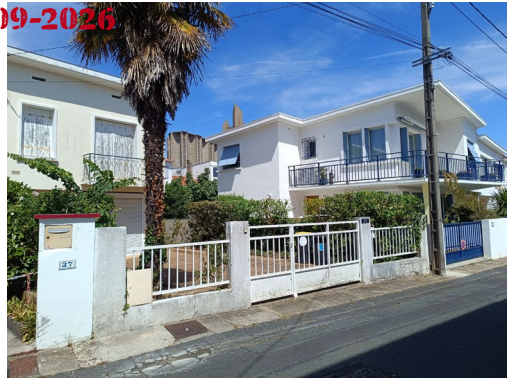
12. Vue Sud-Ouest depuis la rue des Moulins
