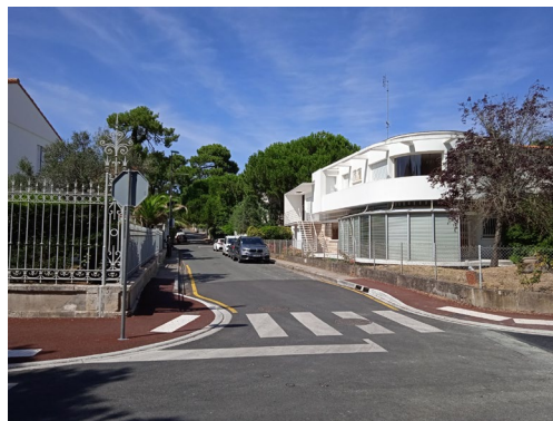
2. Vue sur l'angle Sud-Ouest
