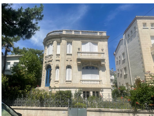
3. Façade Sud-Ouest sur l'avenue du Parc
