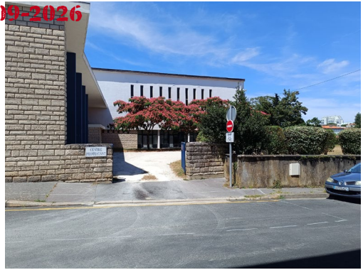
6. Vue de la façade Sud depuis la rue Eugène Pelletan
