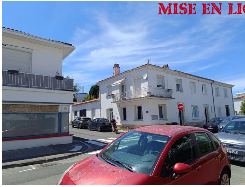
5. Vue Est depuis la rue Pierre Loti
