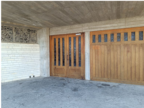
9. Vue d'une entrée sur la façade Est
