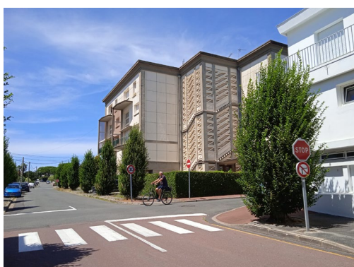
3. Vue Nord depuis la rue du docteur Audoin
