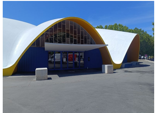
10. Vue de la façade Est
