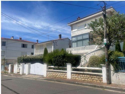
9. Vue Sud depuis la clôture avenue du Parc
