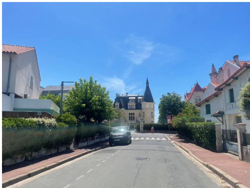
11. Façade Est depuis l'avenue de l'Atlantique
