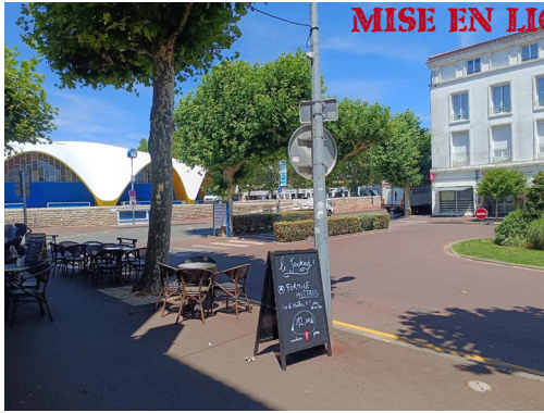
11. Vue façade Sud depuis le boulevard Aristide Briand
