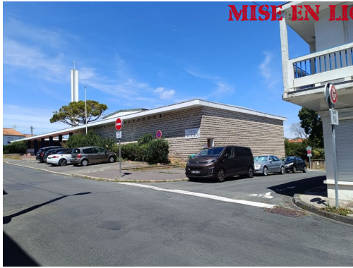
5. Vue de l'angle Sud depuis la rue d'Aunis
