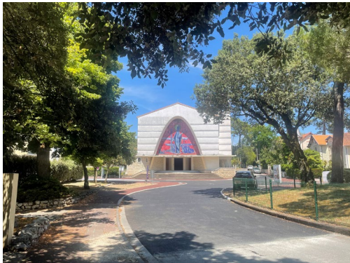
9. Façade Sud depuis l'avenue des Chênes Verts
