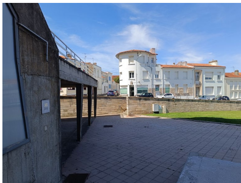
8. Vue Nord vers la rue du Château d'Eau
