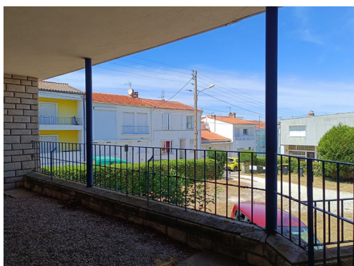
3. Vue depuis l'intérieur vers la rue Alsace-Lorraine
