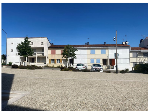
1. Vue vers la rue du Clouzit
