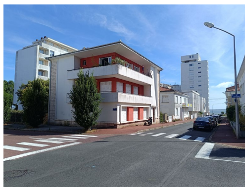
4. Vue vers le Sud depuis l'angle du bâtiment
