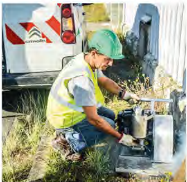
Test "à la fumée" pour la vérification des réseaux.
