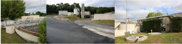
Travaux de la STEP de Saint-Georges-de-Didonne.
