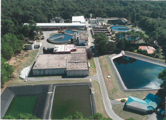
Deux millions d'euros seront affectés aux travaux à la station d'épuration de Saint-Palais-sur-Mer (en photo) et à celle de Saint-Georges-de-Didonne.
