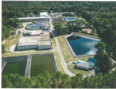
La station d'épuration située à Saint-Palais traite près de 70% du volume d'eaux usées du Pays royanais. (CARA / Sébastien Naud)
