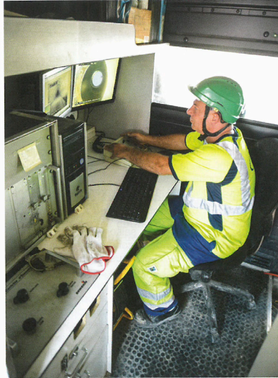
Utilisation d'une caméra pour l'inspection télévisée des réseaux
