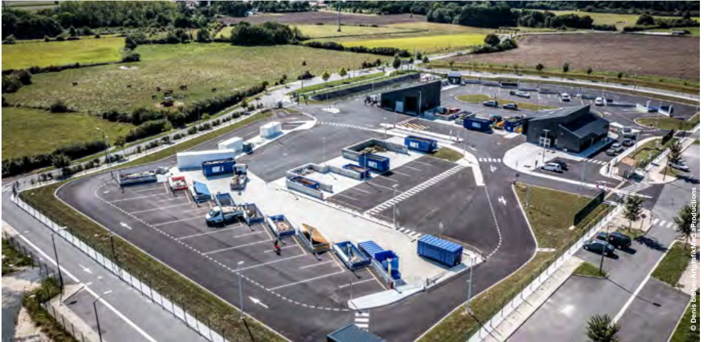
Juillet 2021 : ouverture de la nouvelle déchèterie située à Arvert.
