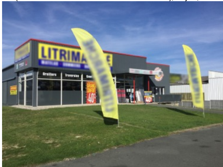
Rue Lavoisier, enseignes scellées au sol ou installées directement sur le sol avec un format important (non-conformes au code de l'environnement), Royan, octobre 2017.
