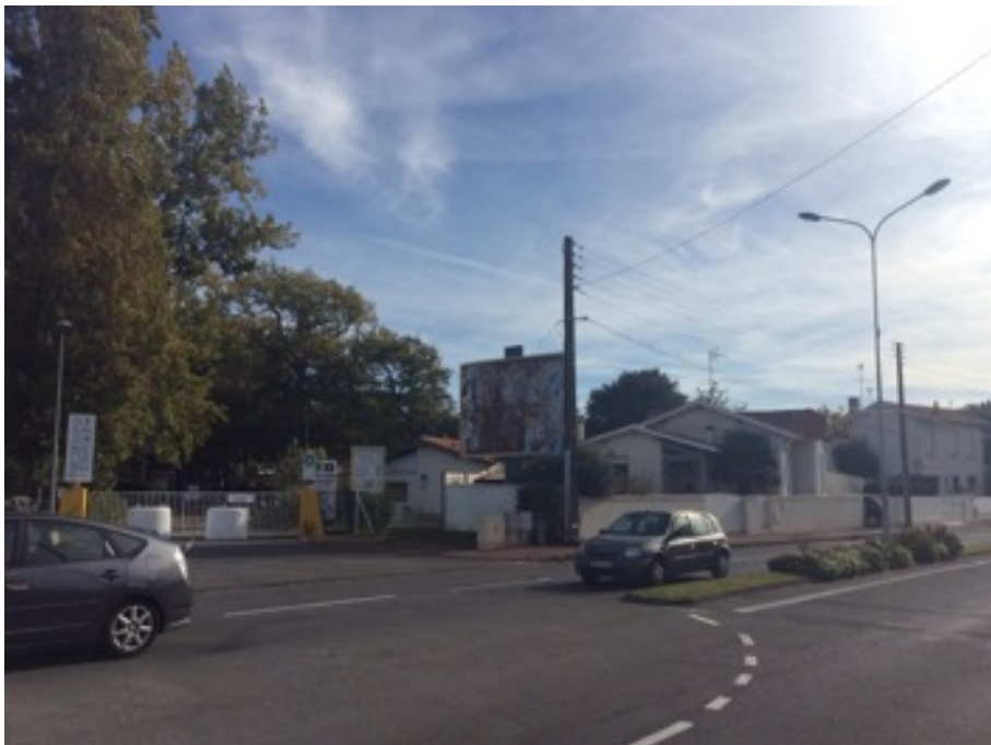
Avenue Aliénor d'Aquitaine, dispositif en mauvais état d'entretien, Royan, octobre 2017.
