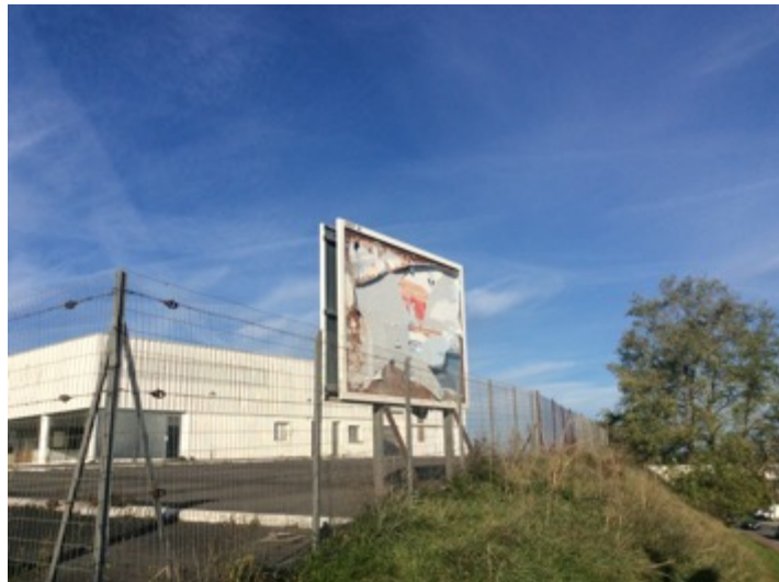
Rue Antoine Laurent De Lavoisier, dispositif en mauvais état d'entretien, Royan, octobre 2017.
