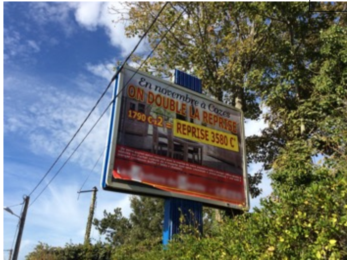
Avenue Charles Regazzoni, dispositif en mauvais état d'entretien, Royan, octobre 2017.
