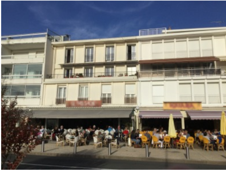
Avenue de Pontailac, enseigne sur toiture ou terrasse en tenant lieu réalisée sans lettres découpées, Royan octobre 2017
