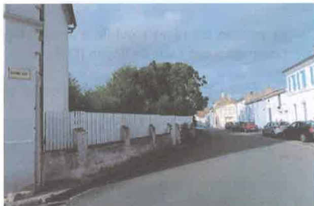
La Grand-Rue sera fermée à la circulation, entre la mairie et le port, à partir du 1 er octobre et jusqu'en mars 2019. L'accès aux commerces du centre-bourg sera maintenu pendant les travaux. Une déviation sera mise en place par la RD 733 pendant le chantier. Les travaux seront interrompus du 22 décembre au 13 janvier, pour les fêtes de fin d'année.
