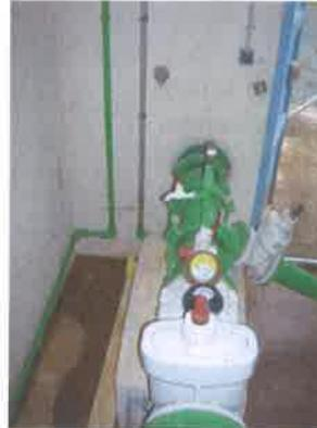
Une mesure de conductivité et de turbidité permet de suivre la qualité de l'eau pompée (risque d'eau saline).
