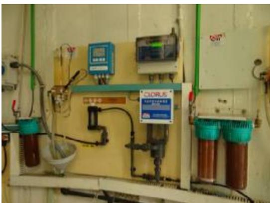
Figure. 57: Système de chloration au chlore gazeux (château d'eau et forage)
