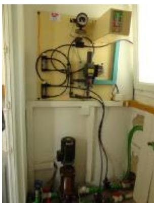
Figure. 31: Système de chloration
