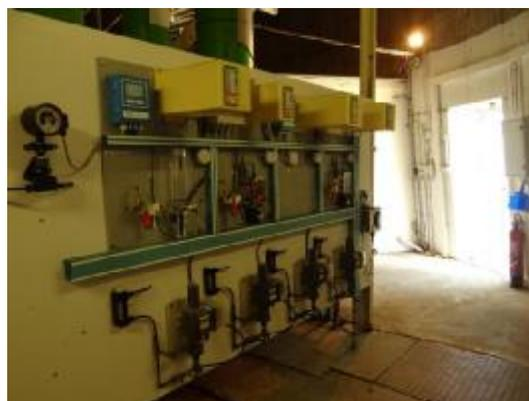
Figure. 48 : Equipement de chloration
