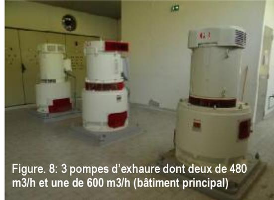
Figure. 8: 3 pompes d'exhaure dont deux de 480 m<sup>3</sup>/h et une de 600 m<sup>3</sup>/h (bâtiment principal)
