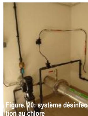
Figure. 20: système désinfection au chlore
