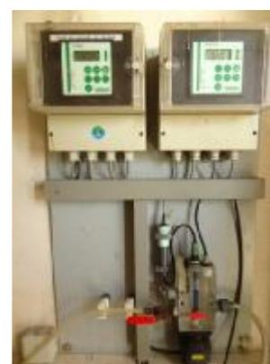
Figure. 35 : Système chloration pour B2
