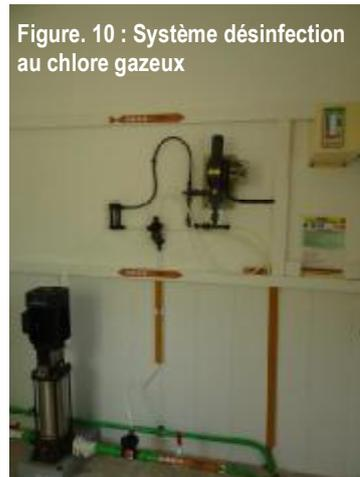
Figure. 10 : Système désinfection au chlore gazeux
