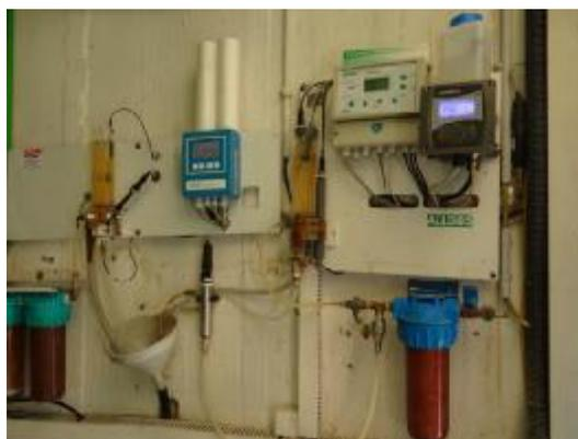
Figure. 44 : Equipements de mesure en continue (conductimètre)
