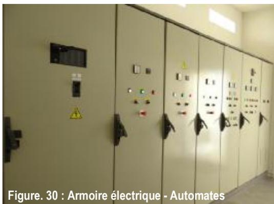
Figure. 30 : Armoire électrique - Automates
