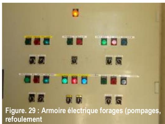
Figure. 29 : Armoire électrique forages (pompages, refoulement)
