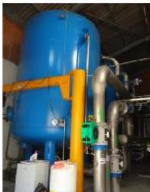
Figure. 26 : Filtres CAG (Charbon Actif en Grain). Deux files de traitement soit 6 filtres au total (trois par trois)
