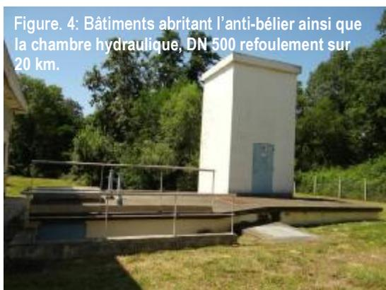
Figure. 4: Bâtiments abritant l'anti-bélier ainsi que la chambre hydraulique, DN 500 refoulement sur 20 km.
