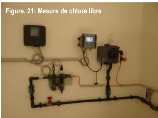
Figure. 21: Mesure de chlore libre
