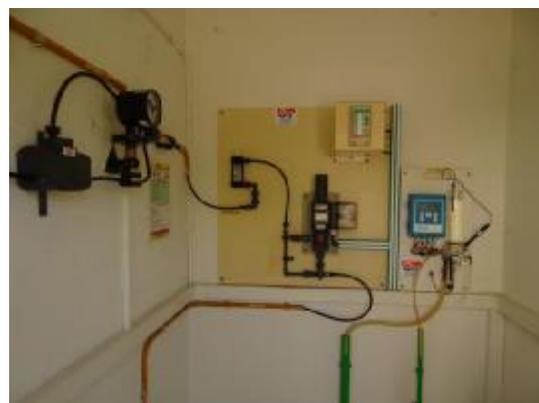
Figure. 65: Chloration (bâtiment technique)
