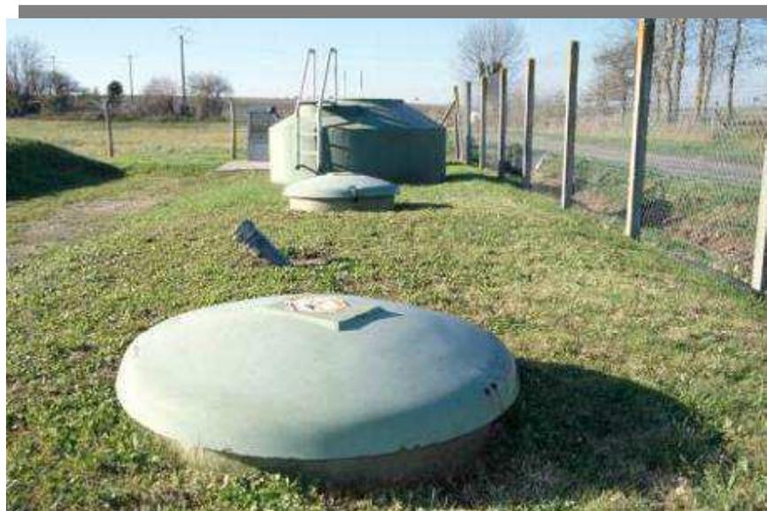
\* Après un prétraitement et une décantation primaire, les eaux sont traitées par lits bactériens de type Bioclère. Les eaux traitées subissent un traitement tertiaire par filtration sur sable et chloration.
