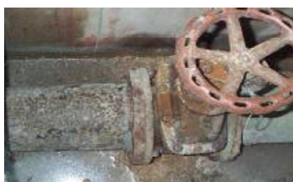
Remplacement des pièces de fontainerie corrodées
